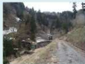
土石流危険渓流 深間工が整備されている。
