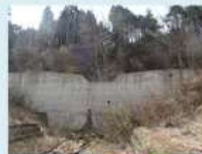
既設 治山ダム
